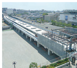
建設中の箕面萱野駅
