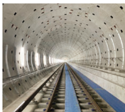
工事中のシールドトンネル内
