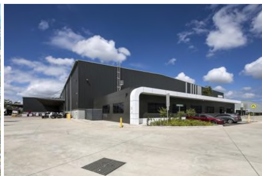
シドニー市の物流倉庫
