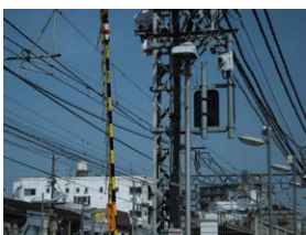
踏切監視カメラ
