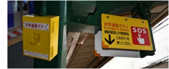
非常通報ボタンと案内板
