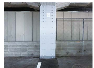
一面せん断補強工法
