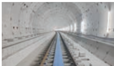
工事中のシールドトンネル内
