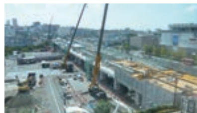
工事中の箕面萱野駅
