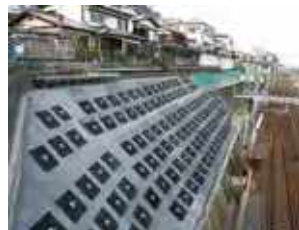
線路脇の土砂崩れ防止工事
