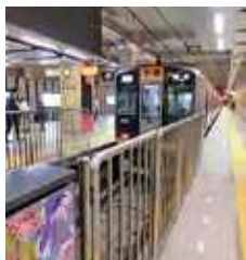
阪神神戸三宮駅の転落防止柵
