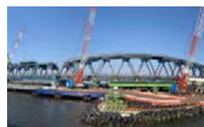
河川内の施工状況
