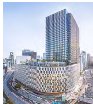
大阪梅田ツインタワーズ・サウス
