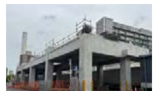
高架構造物の構築
