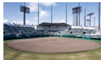
日鉄鋼板 SGLスタジアム 尼崎
