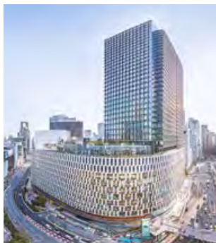
大阪梅田ツインタワーズ・サウス
