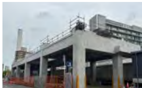
高架構造物の構築
