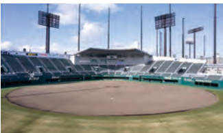
日鉄鋼板 SGLスタジアム 尼崎
