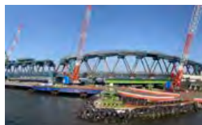
河川内の施工状況
