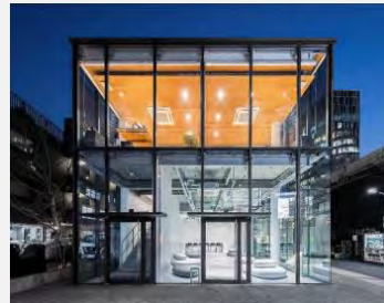
「H-CUBE北青山」※（商業施設）
