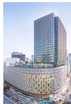
大阪梅田ツインタワーズ・サウス
