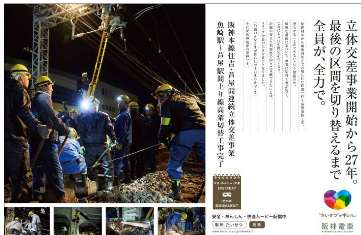
▲ 特別編「阪神本線住吉・芦屋間連続立体交差事業 魚崎駅～芦屋駅間上り線高架切替工事」
