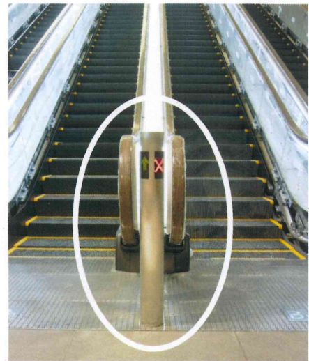
エスカレーター乗降口に設置するLEDサインポール （写真マル枠内）→
