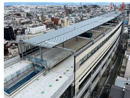
高架化工事中の淡路駅
