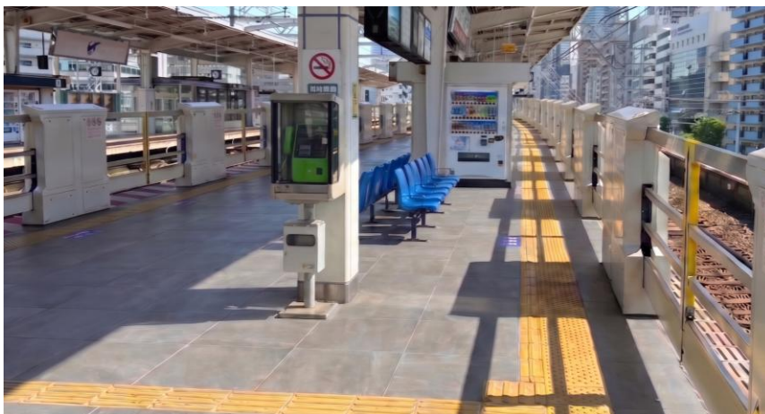
〈改良工事後の野田駅イメージ（2027年度竣工予定）〉
