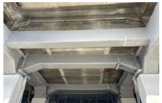
〈高架下補強後の様子〉
