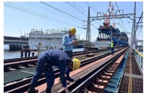
〈線路の状態確認の様子〉
