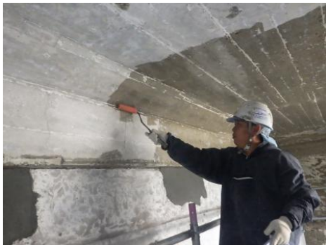
〈高架下の長寿命化工事の様子〉
