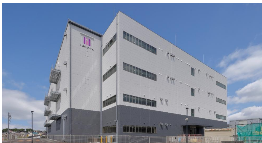
「ロジスタ北伊丹」（6月30日竣工）
