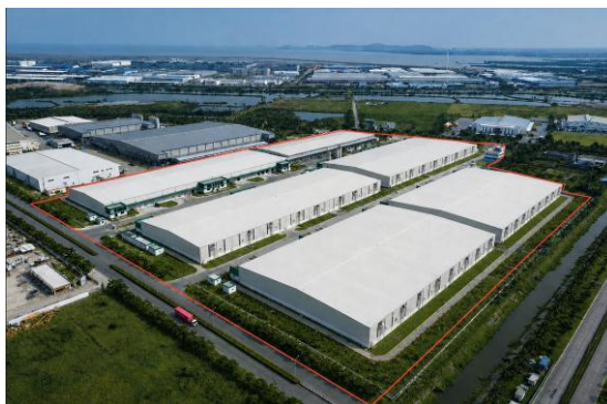
セムコープ ロジスティクスパーク（ディンブー）外観 ※赤枠内の 6 棟が本プロジェクトにおける開発物件です。 このうち、一番奥右手の 1 棟は既存倉庫の取得です。
