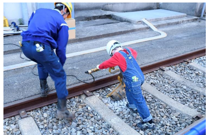
<道床つき固め体験（前回の様子）>
