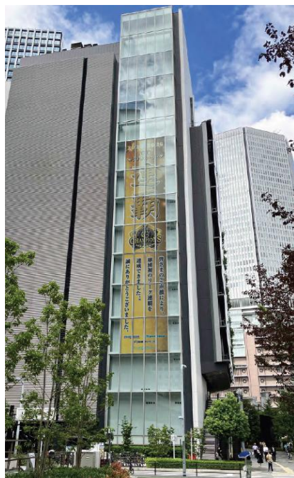
大阪梅田ツインタワーズ・サウス 東南部 ガラス面（イメージ）
