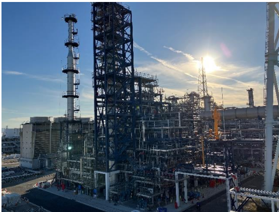
建設が完了した SAF 製造装置 (コスモ石油堺製油所構内)
