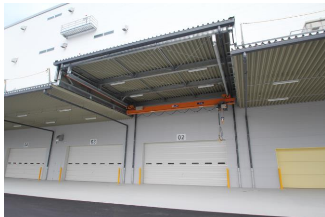
大庇と天井クレーン
