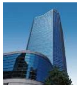
インテックビル（タワー111）
