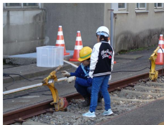
< 道床つき固め体験（前回の様子） >
