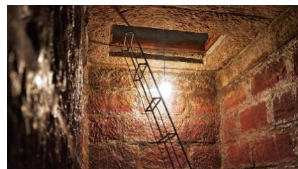
▲明治期から使用される ルミエールワイナリーの地下発酵槽
