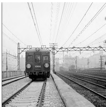
③ 京都本線（梅田～十三駅間）の増設により三複線が完成し、試運転を行う列車の様子
