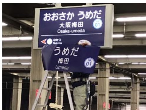
⑥ 終電後に行った駅名看板の取替作業の様子
