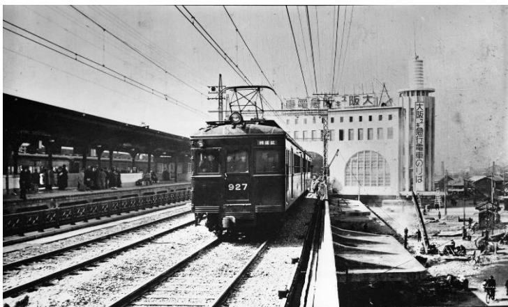
①完成した高架線を走る試運転列車(1936年4月1日営業開始) 【後方は当時の神戸阪急ビル】
