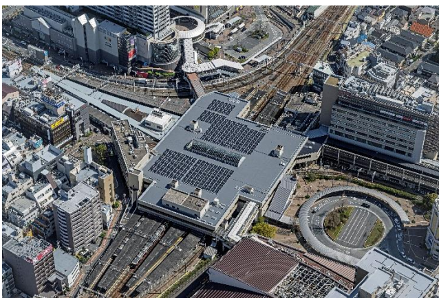
西宮北口駅の太陽光パネル
