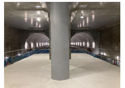
延伸工事（イメージ）
