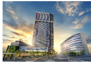
ジオタワー大阪十三（2026年1月竣工予定）
