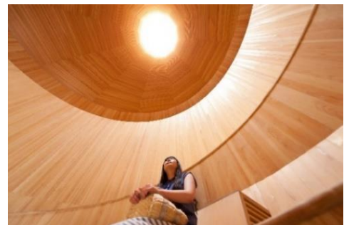
「風室」の天井部分から空気が排出される。
