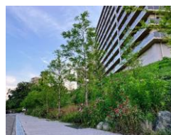
歩道際の法面植栽 (1工区)
