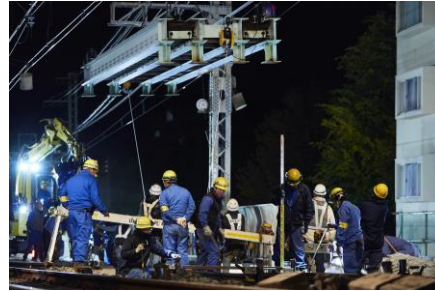
線路切替作業の様子
