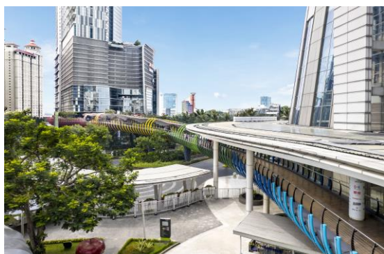
両施設を繋ぐ陸橋
