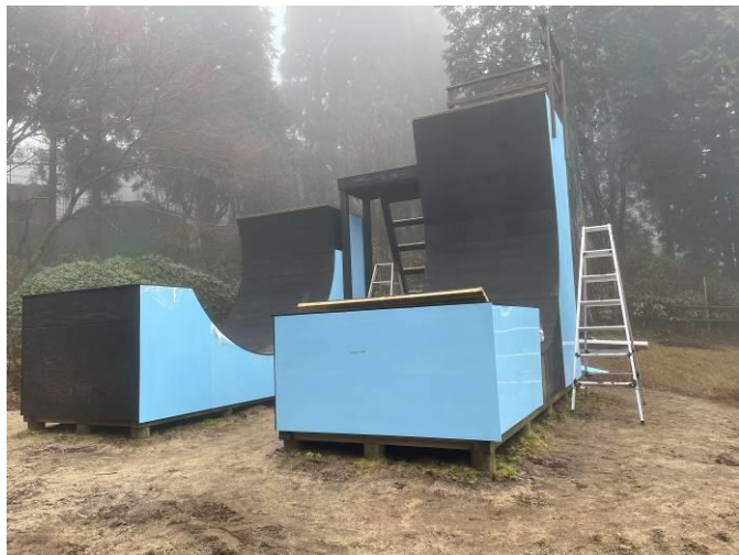
新イベント「フォトアスレチック」施工の様子
