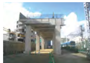
高架橋工事現場
