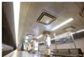
阪急京都線地下空間
