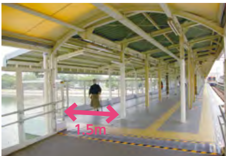
武庫川駅上りホーム
