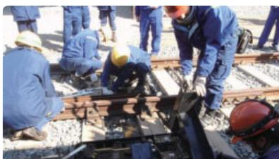
分岐器ポイント不転換の原因究明と応急復旧訓練状況（上下写真とも）
