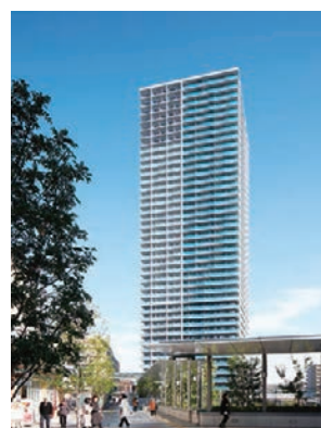
ジオタワー高槻ミューズガーデン
