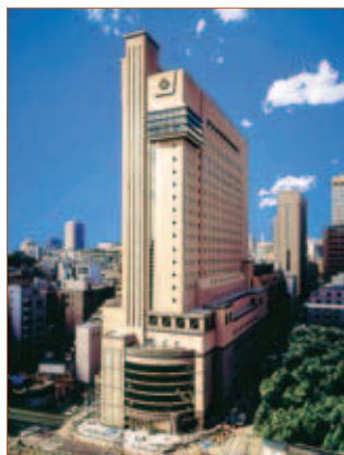
第一ホテル東京 (東京都港区)
