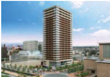
ジオタワー西宮北口（兵庫県西宮市）
