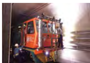
トンネルの定期検査
