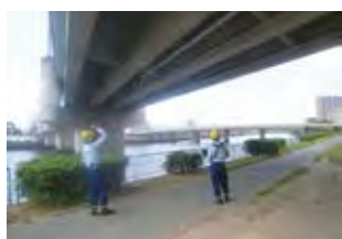
構造物の検査
