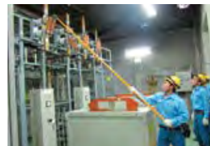
変電所の設備点検
