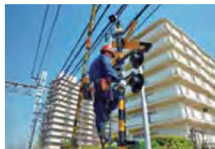
保安通信設備の定期検査
