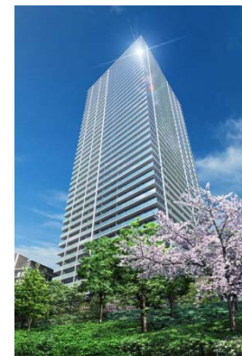
ジオタワー高槻 ミュージズガーデン 2014年12月竣工予定
