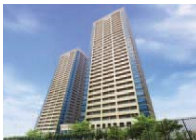
Geo Tower Takarazuka (Takarazuka, Hyogo)
